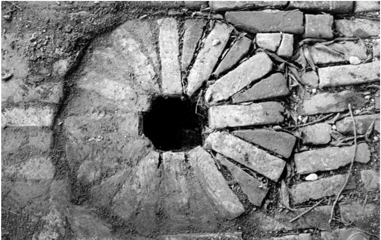
Four industriel de type Hoffmann : détail d'un des orifices à charbon (Ecomusée du Beauvaisis).
