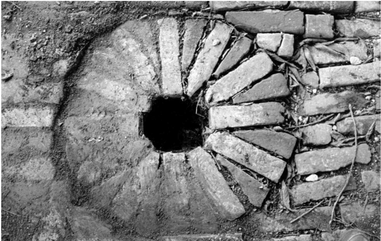
Four industriel de type Hoffmann : détail d'un des orifices à charbon (Ecomusée du Beauvaisis).
