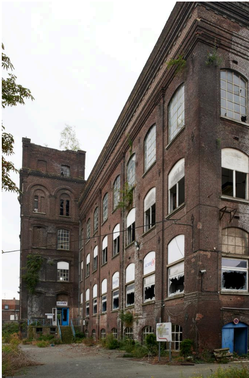
Élévation sud-est de la filature.
