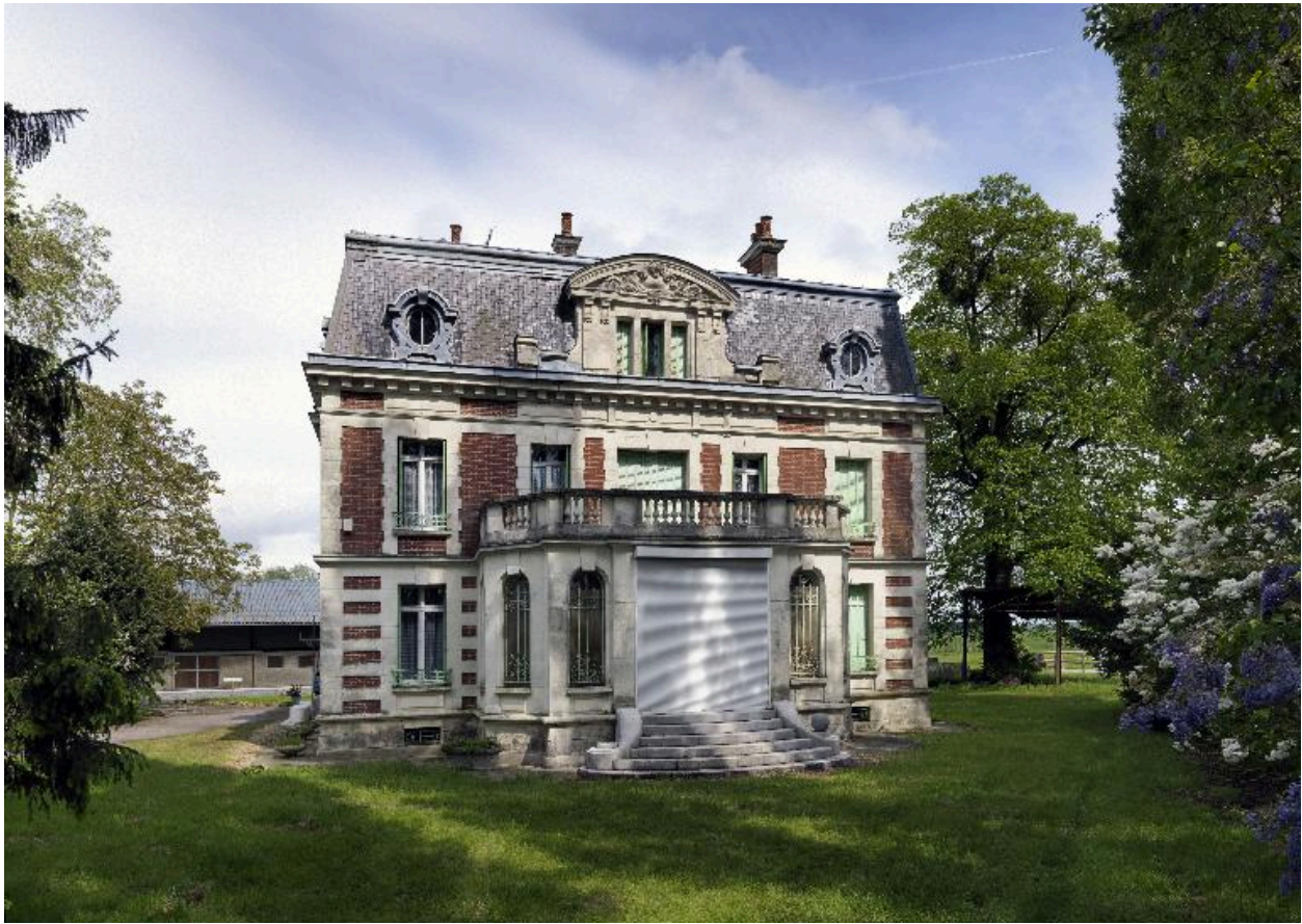
Vue de la façade du château.
