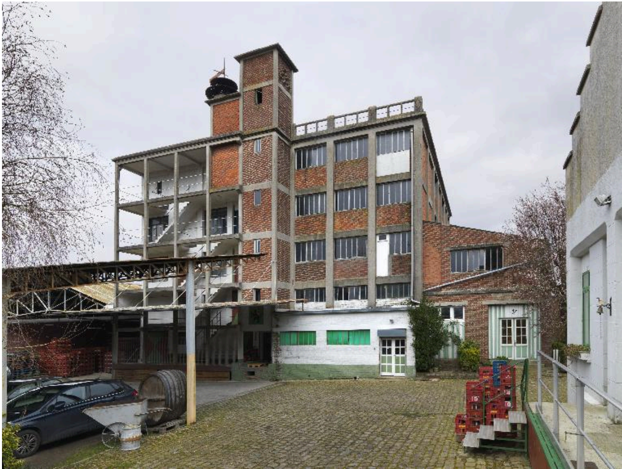
Vue d'ensemble sur cour de la brasserie.
