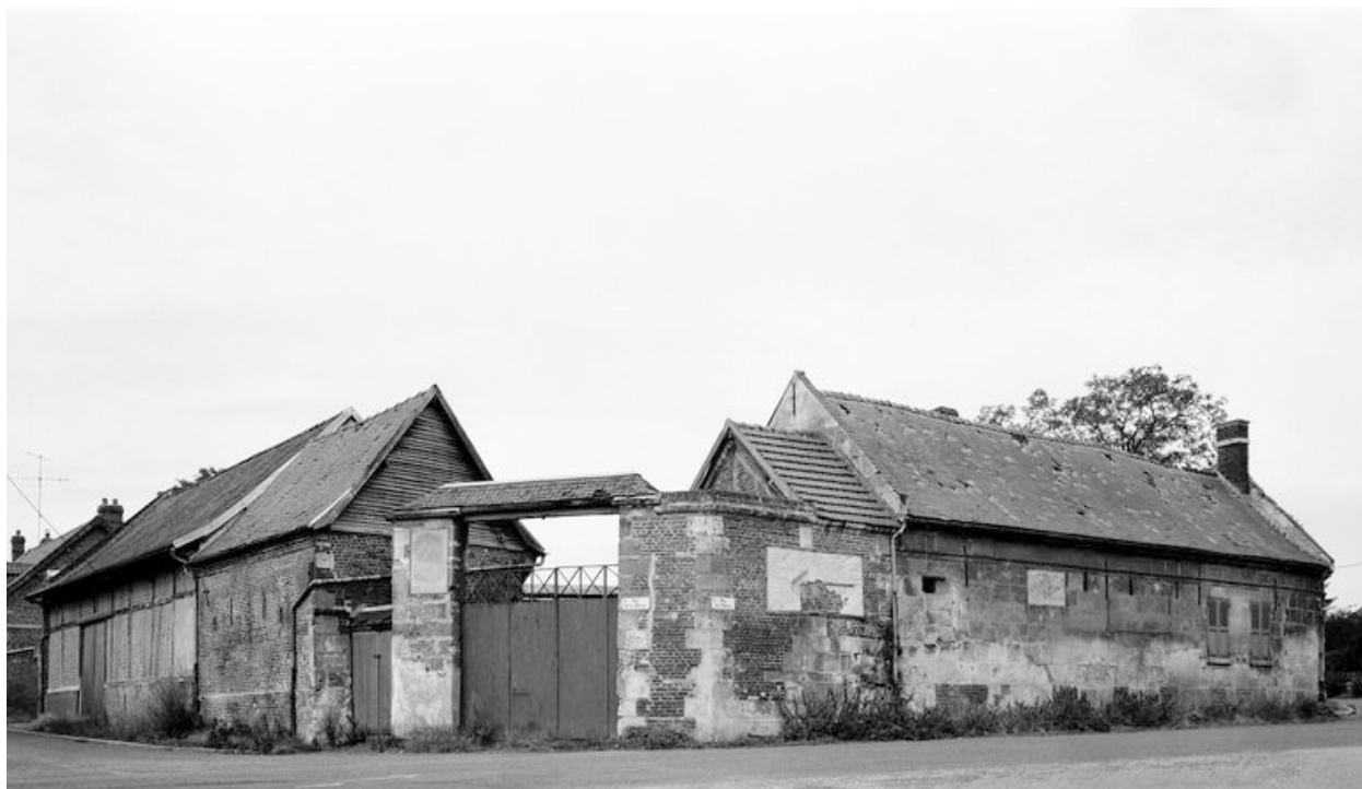
Ferme repérée, élévations sur rue de l'Eglise et rue de la Mairie.
