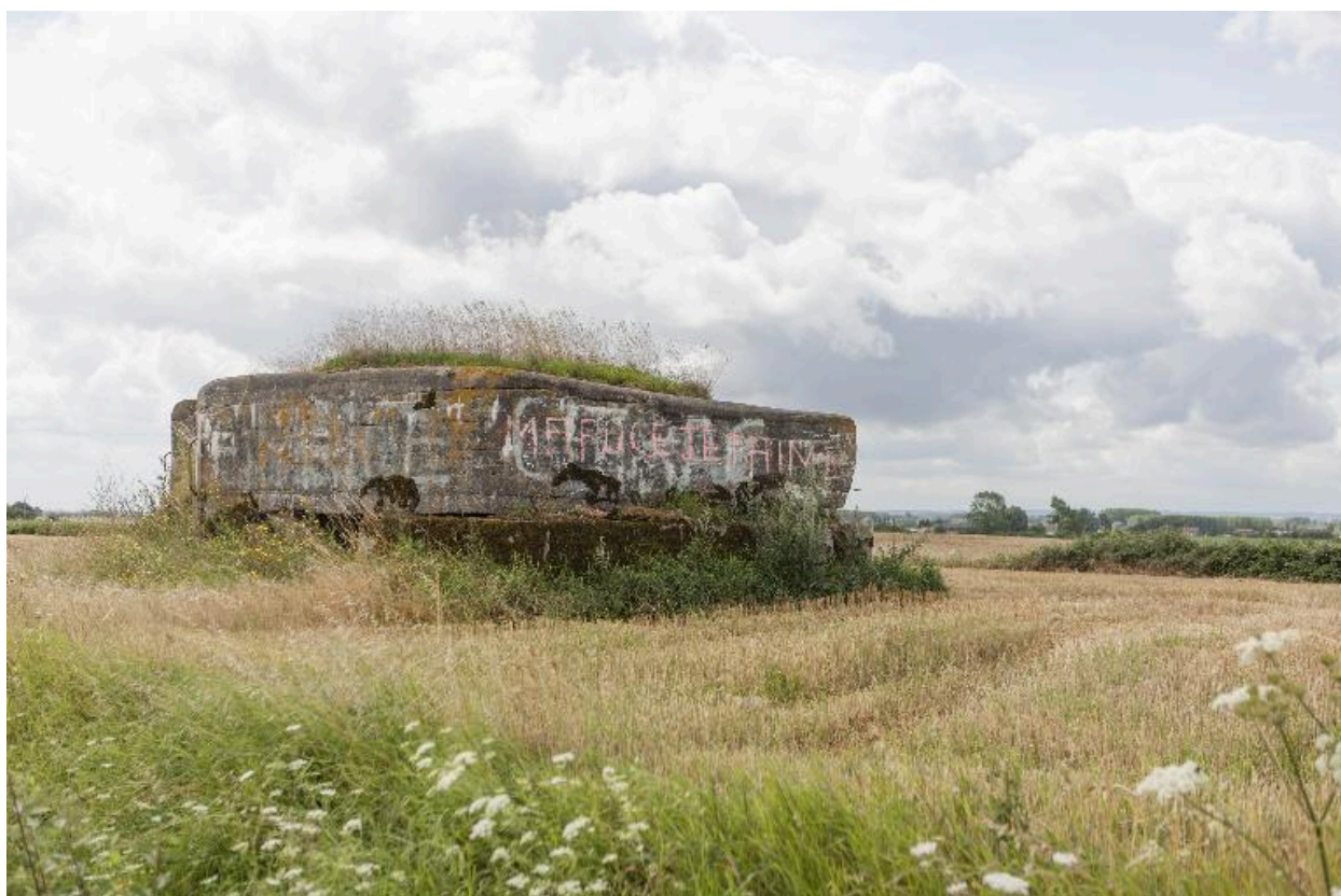
Vue générale, vers le sud
