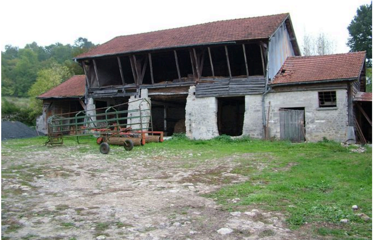
Vue de la grange.
