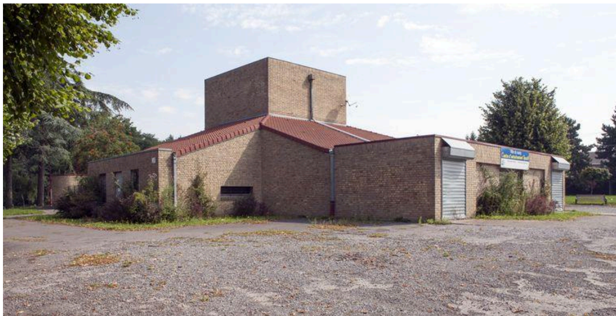
Élévation sud ouest.
