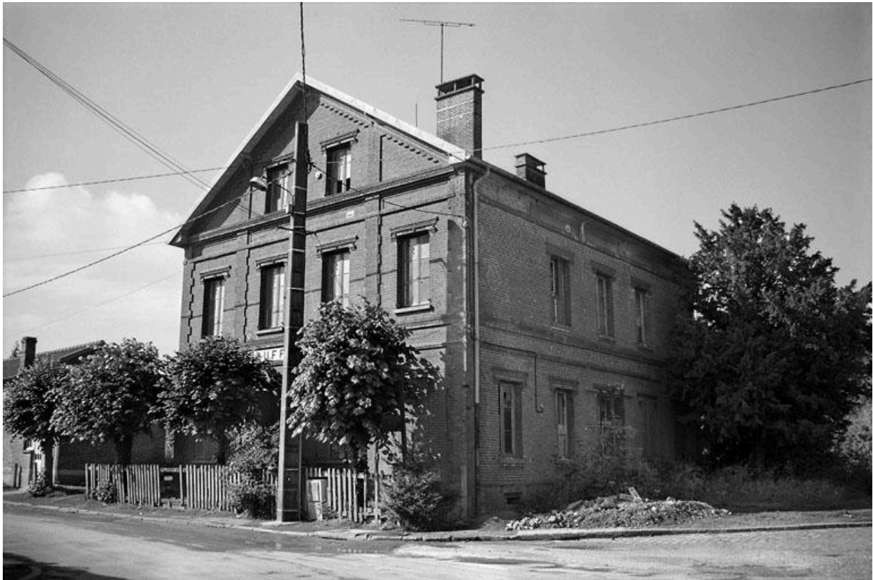
Vue du buffet de la gare, préservé des destructions de la première guerre mondiale.
