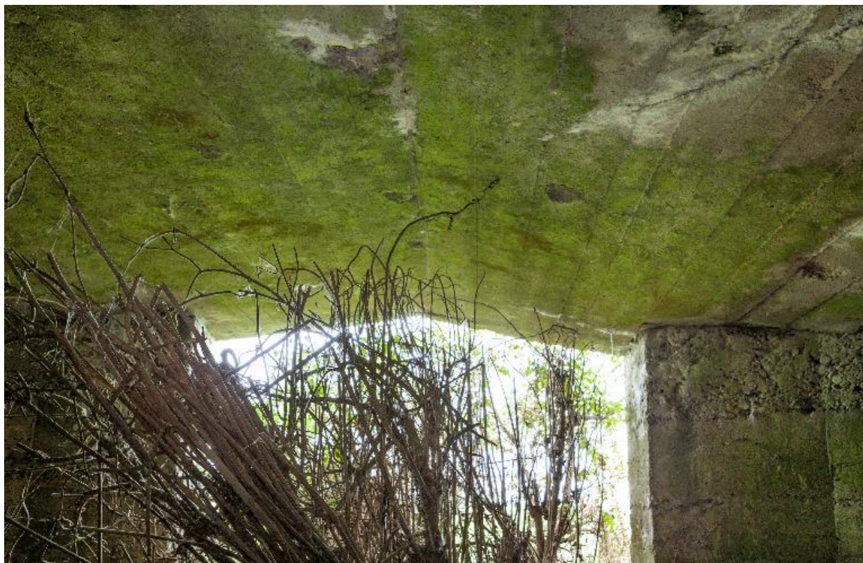
Détail du couvrement de la chambre de tir
