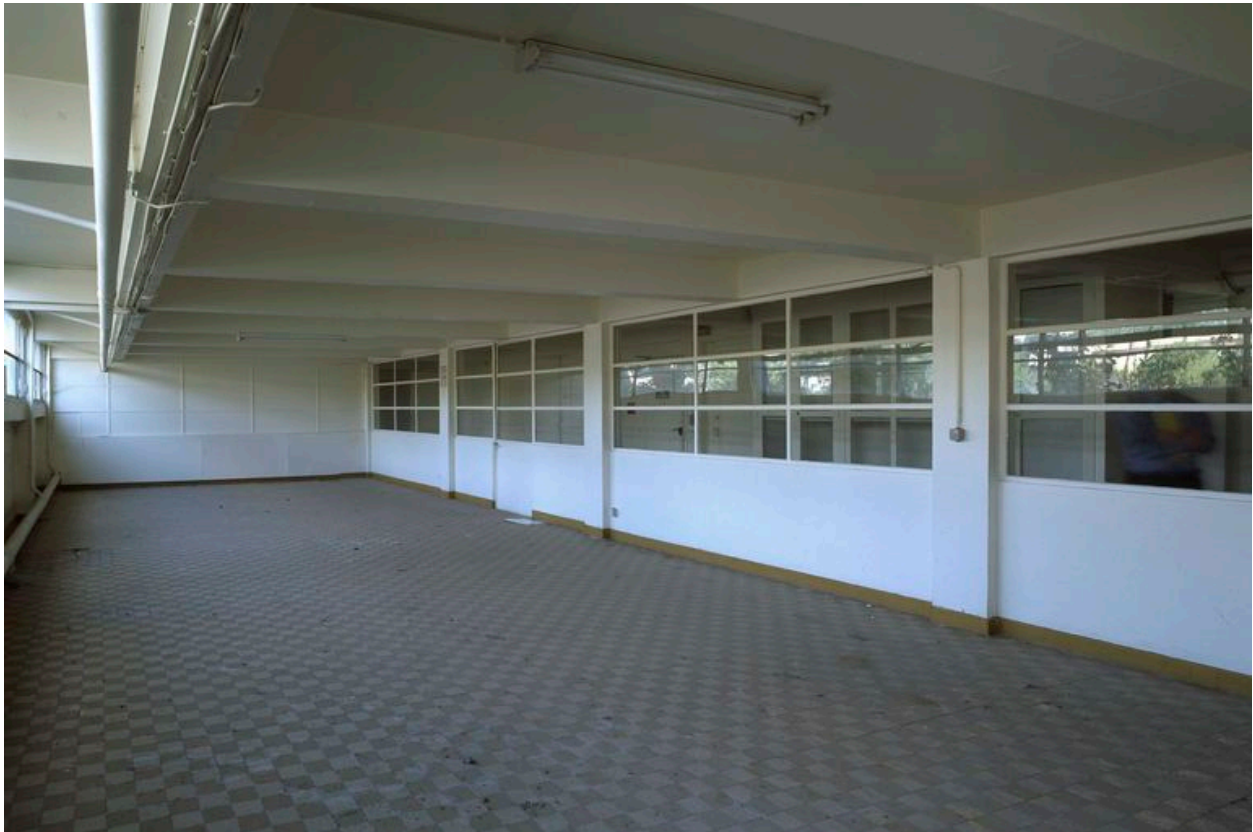
Réfectoire au sous-sol du bâtiment des bureaux.
