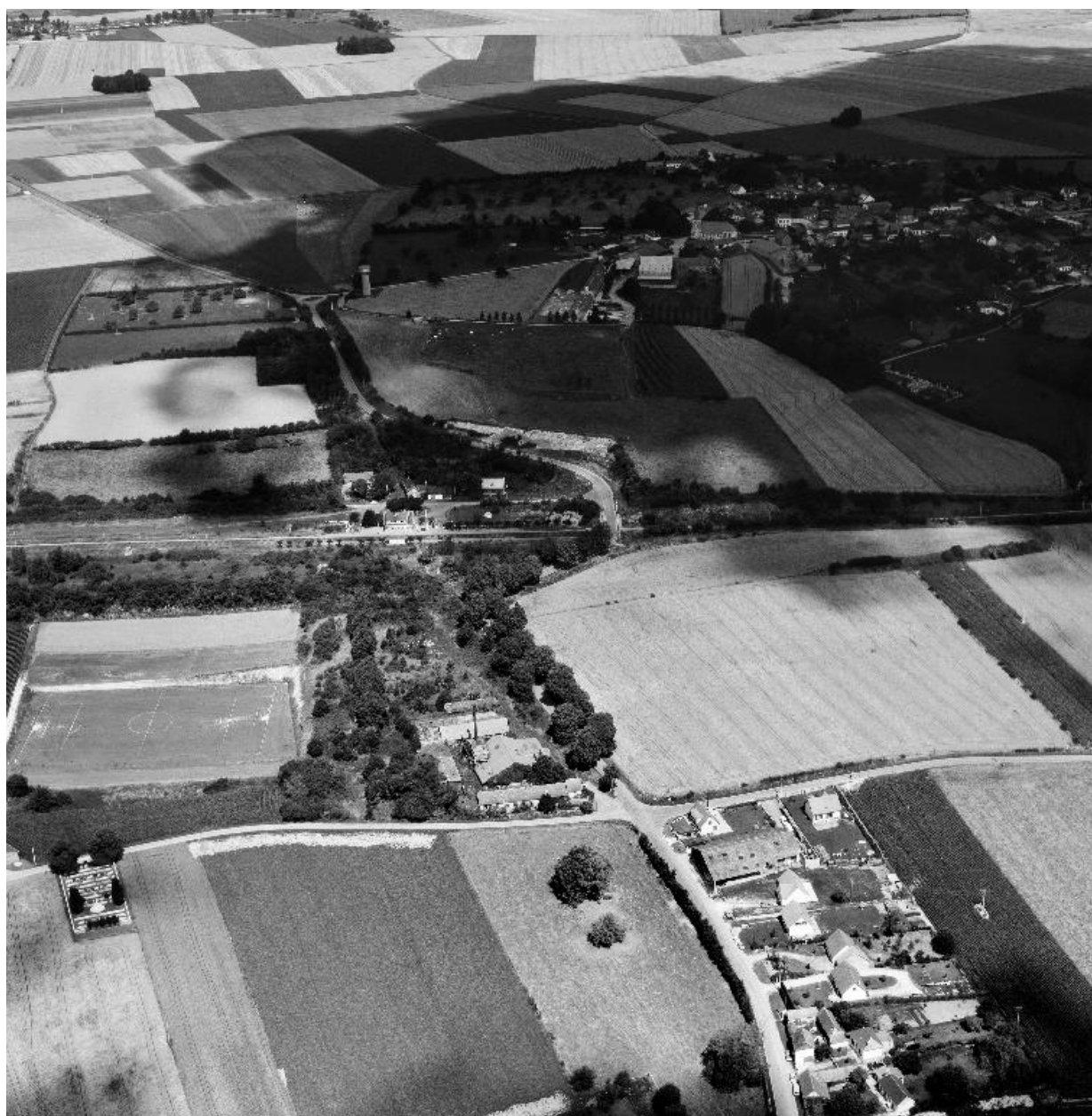
Vue aérienne, flanc sud.
