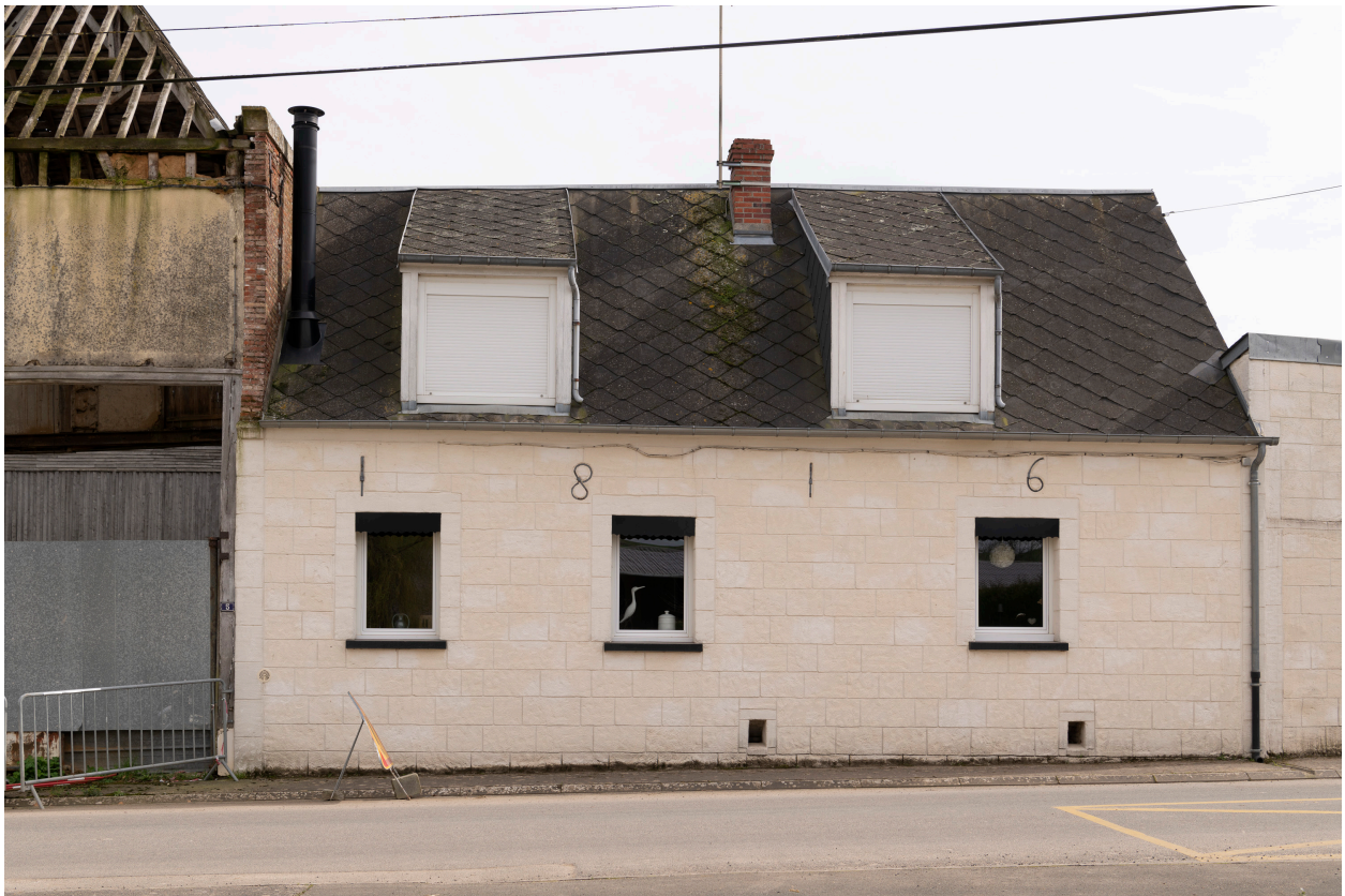
Logis sur rue daté de 1816, façade rénovée, n°7 de la rue Fournier, vue prise depuis le nord.
