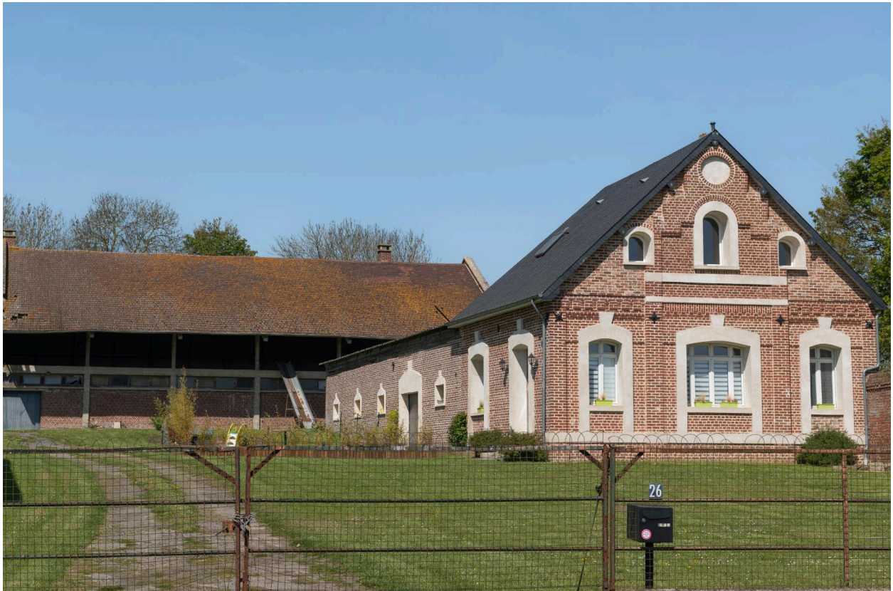
Ancien bâtiment du tissage Lecomte, n°26 de la rue Saint-Pierre, vue prise depuis l'est.
