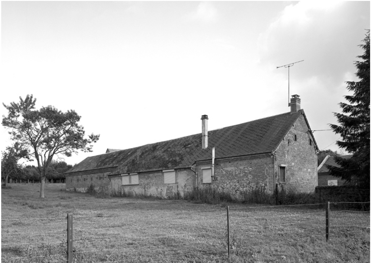
Elévation arrière du logis.
