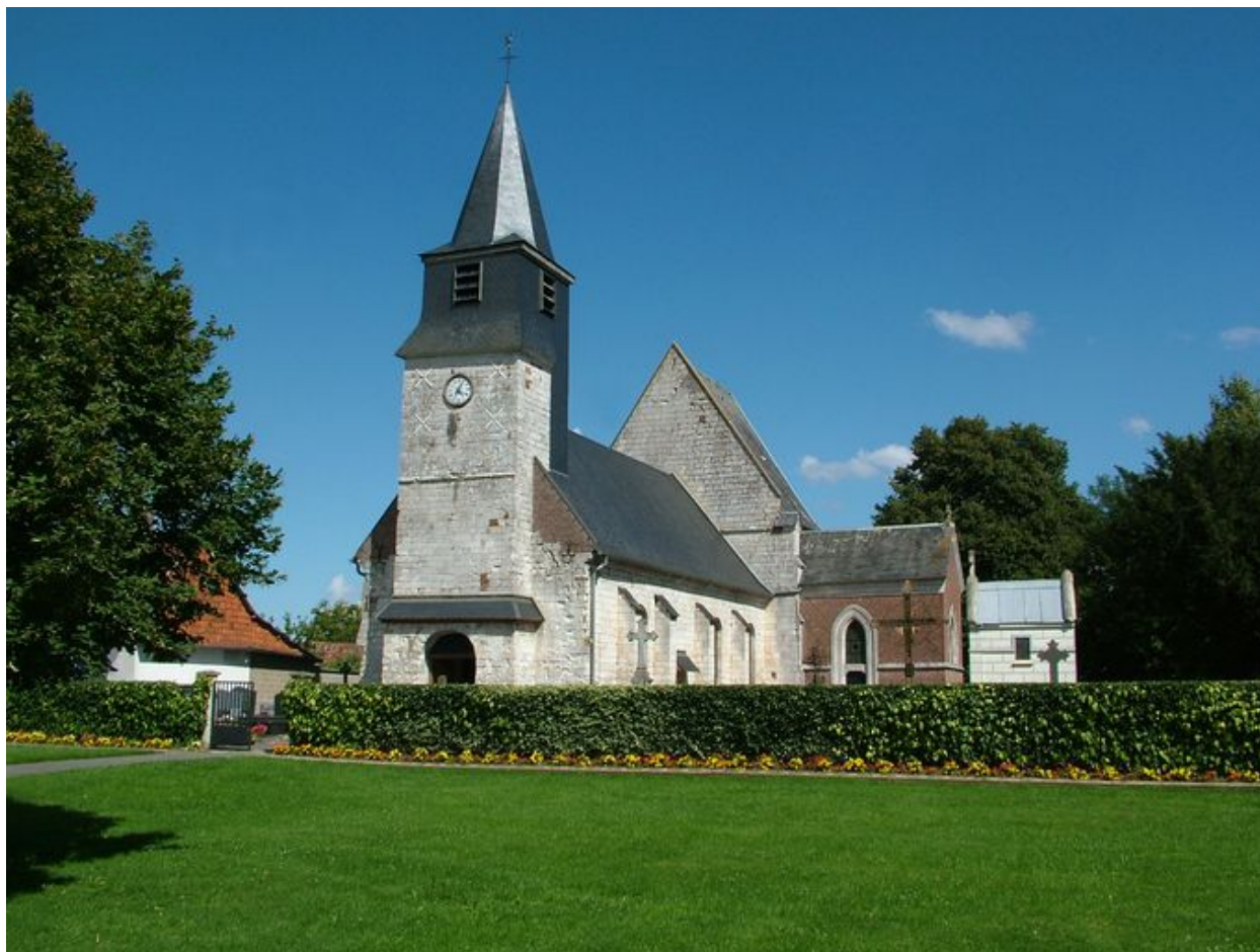
Vue générale depuis l'ouest.
