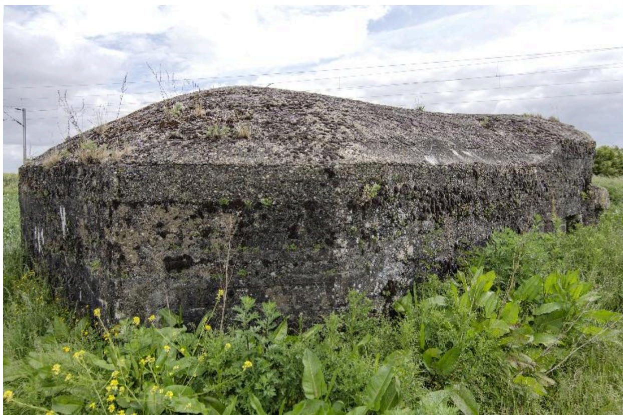
Vue vers de trois-quarts arrière, vers l'est
