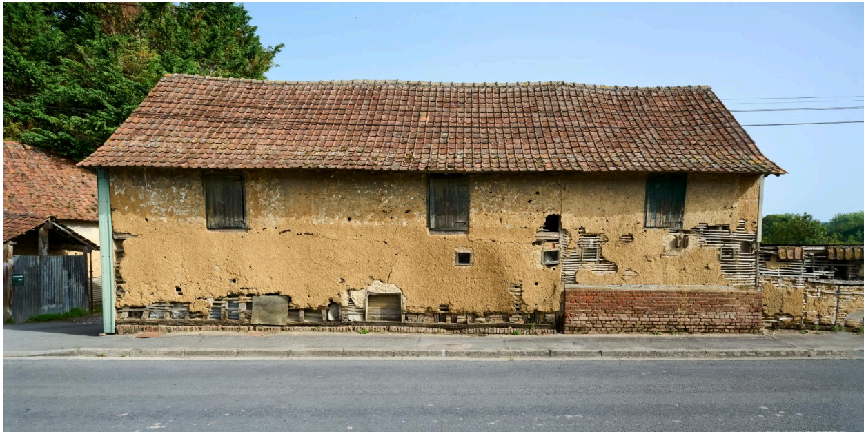
Vue sud d'un bâtiment agricole, depuis la rue.
