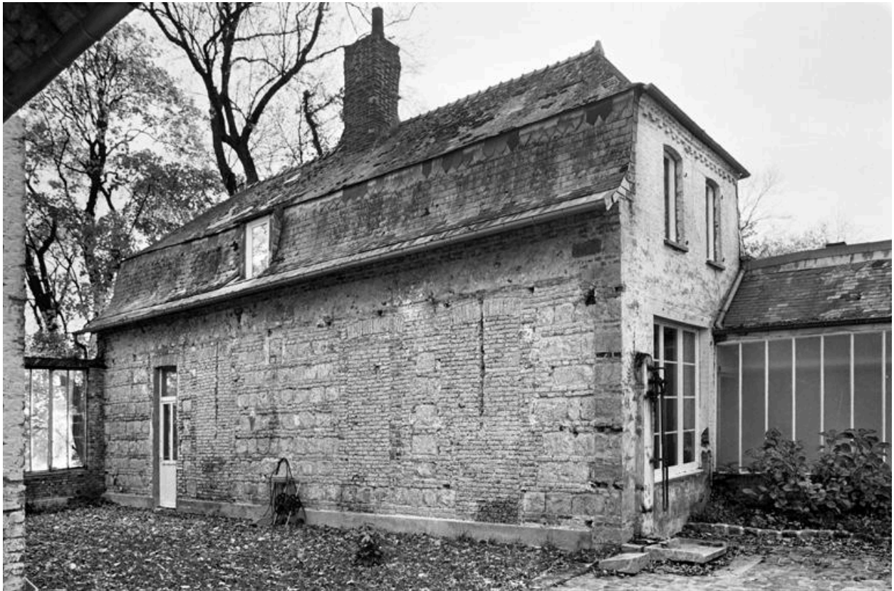
Vue du pavillon occidental et du passage couvert vitré.
