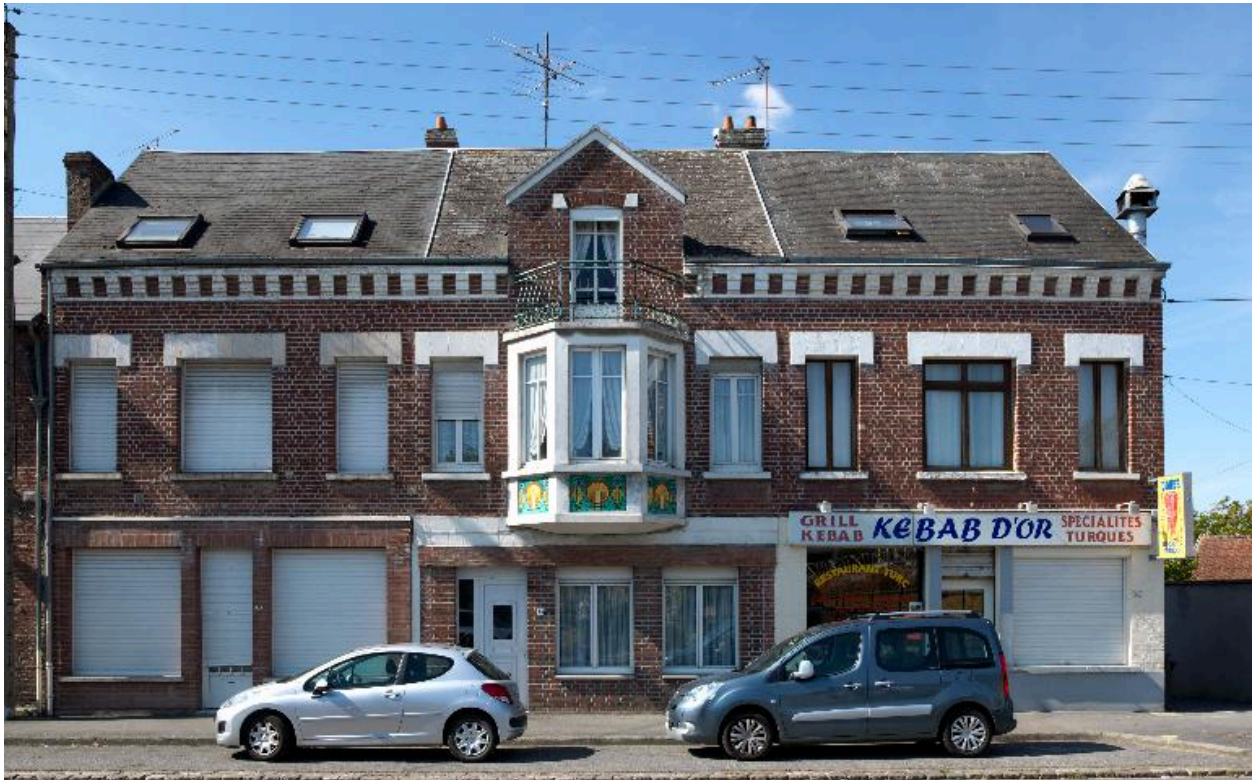
Maison, 34 à 38 rue de Noyon.
