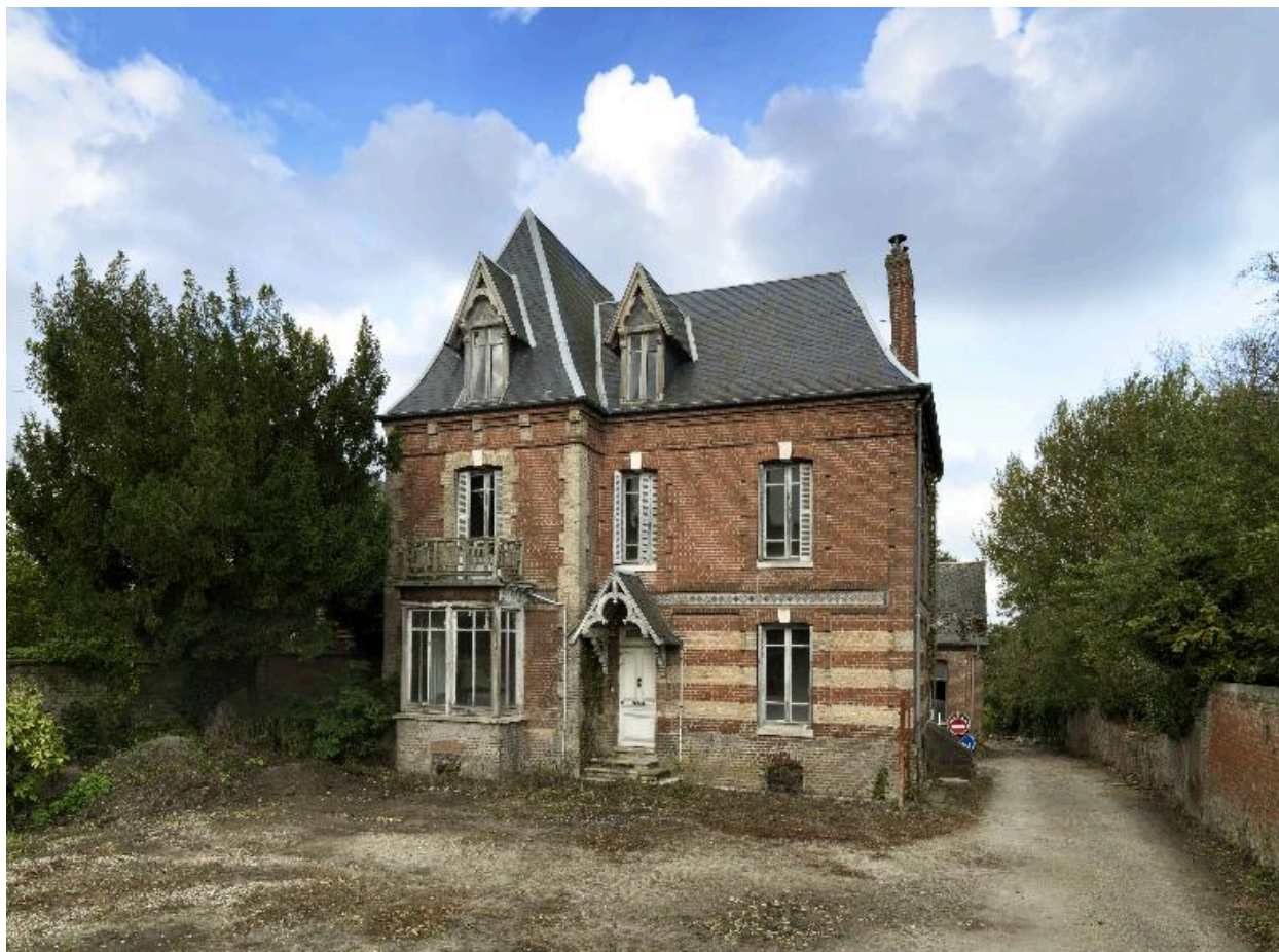
Ancienne maison du directeur de la fonderie, vue depuis la cour.
