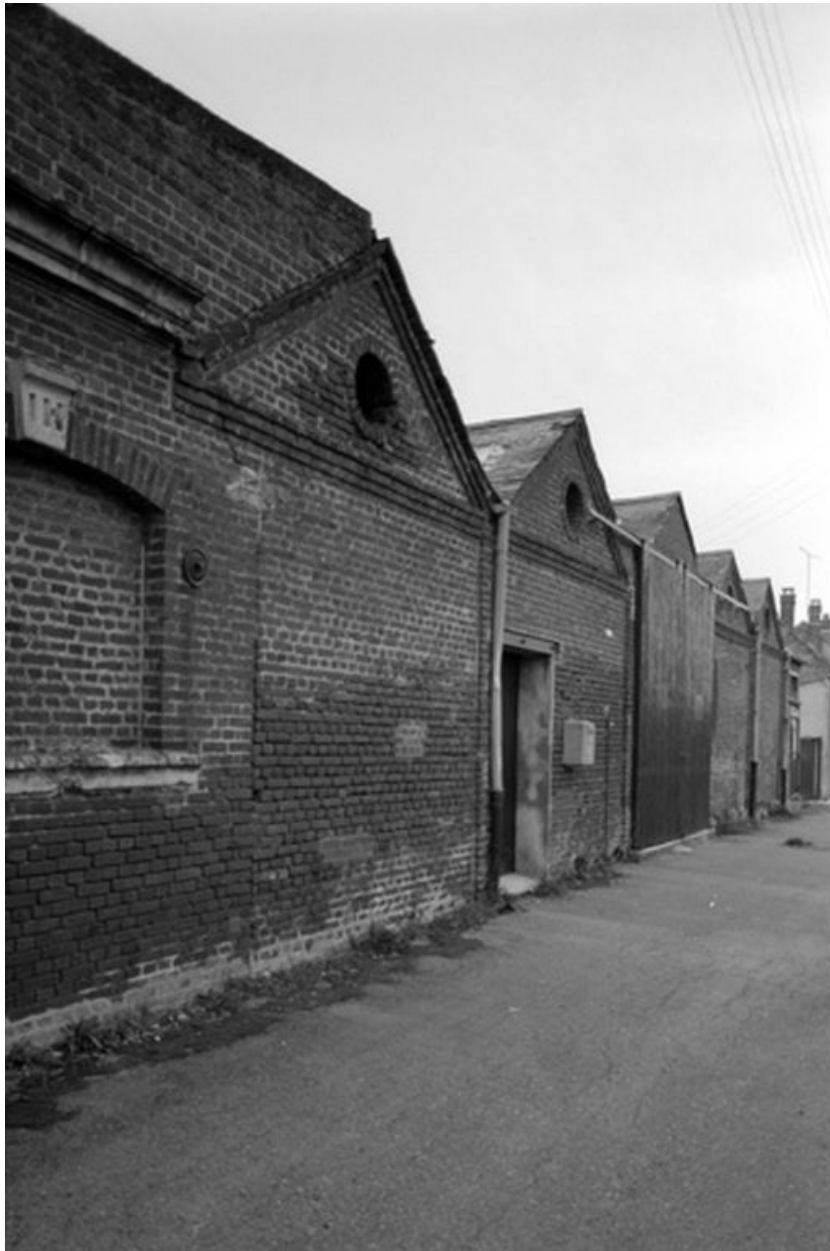
Atelier de fabrication et entrepôts industriels, flanc ouest.
