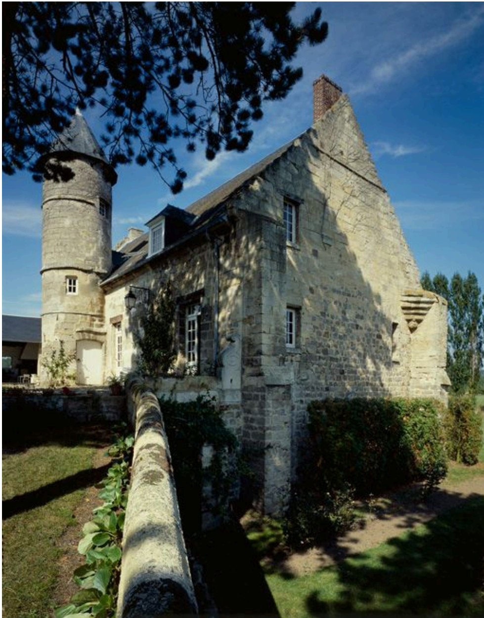
Logis. Pignon sud-est.
