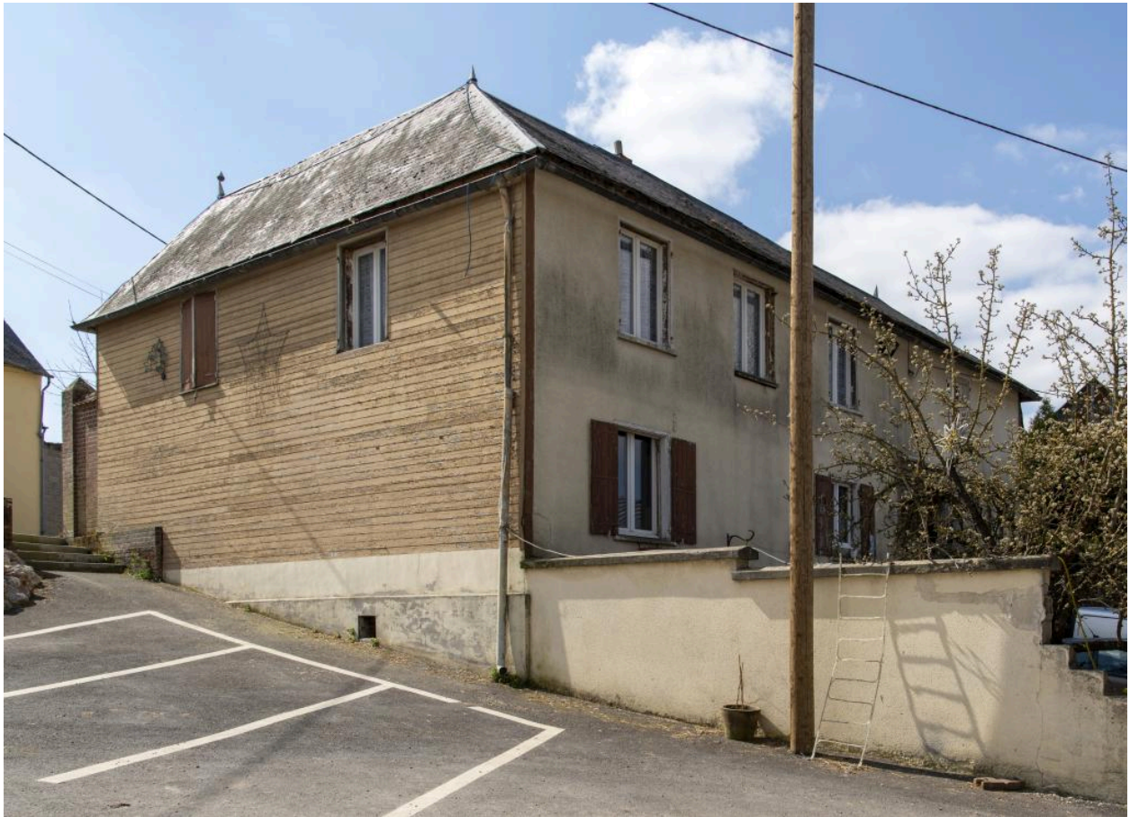
Logis de ferme, n°1 rue Lavaquerie, pignon est et façade nord sur cour, vue depuis le nord-est.
