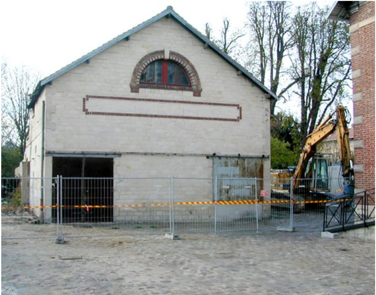
La halle aux vins en cours de démolition, avril 2003 (AC Nogent-sur-Oise).
