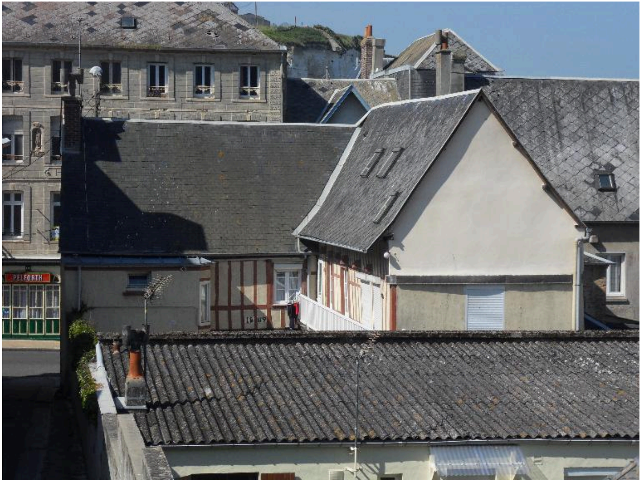
Maison, 7 Grande-rue, façade postérieure.
