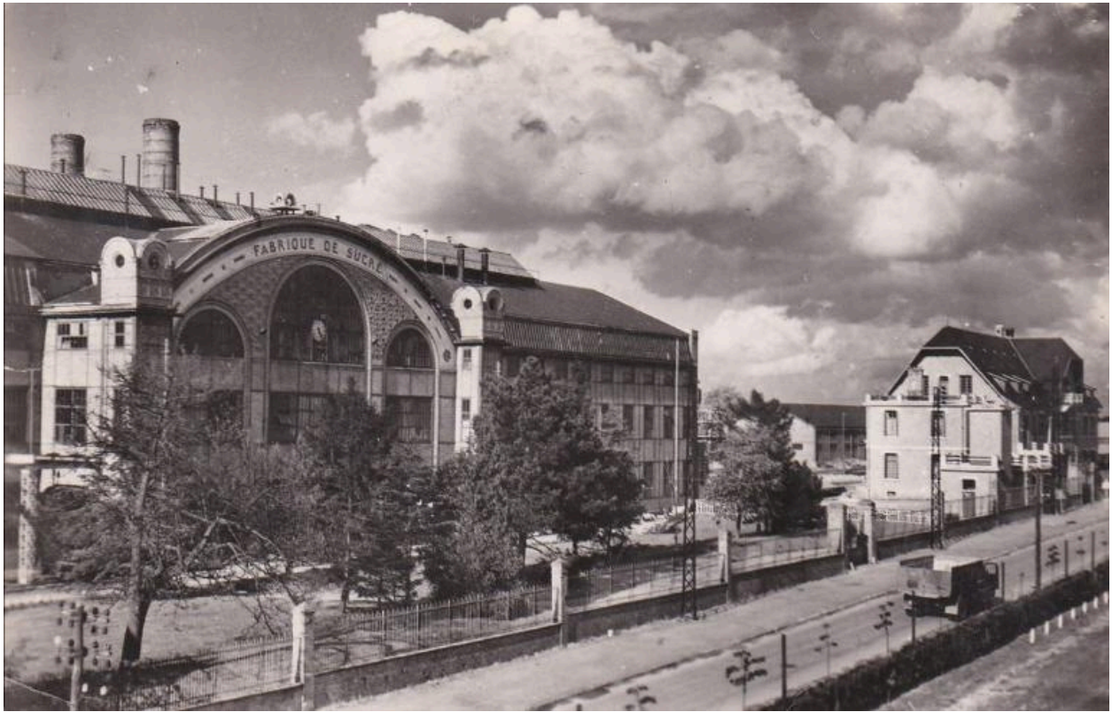
Vue partielle sur rue de la sucrierie et des bureaux, vers 1950 (coll. part.).
