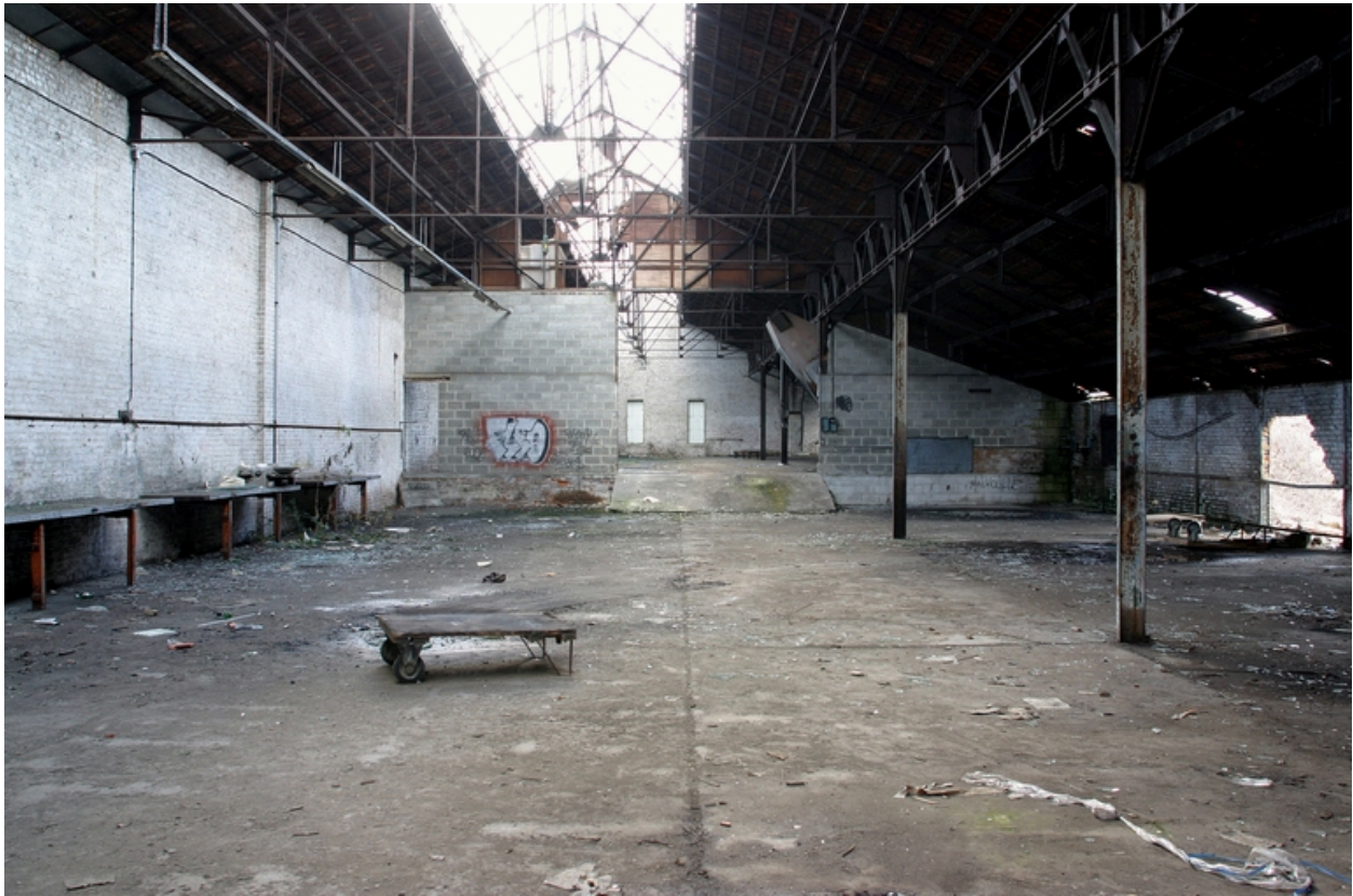
Vue intérieure du magasin industriel.
