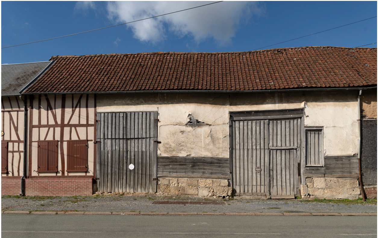
Grange avec deux entrées charretières et une porte à engranger, n°1 de la Place des Déportés, vue depuis le sud.
