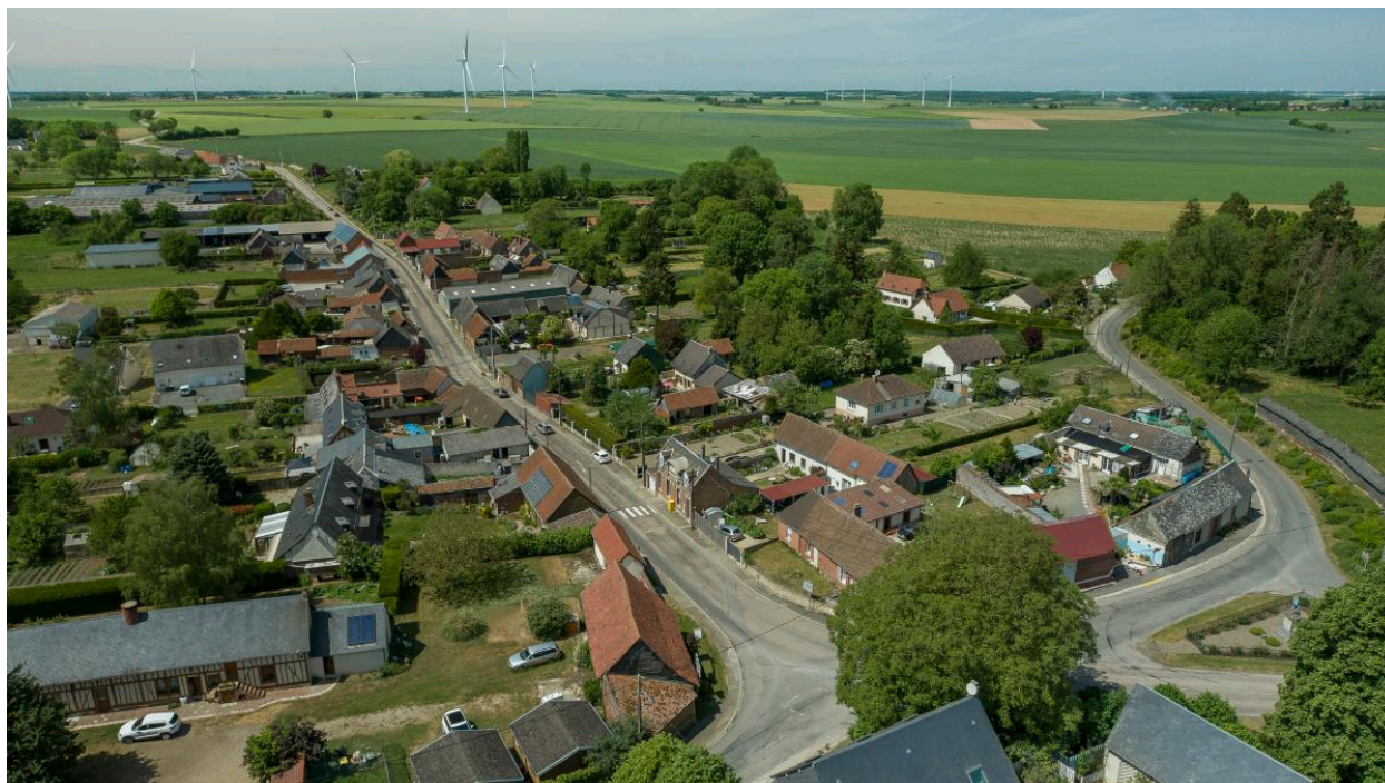
Vue aérienne de la rue Notre-Dame depuis le sud-est.
