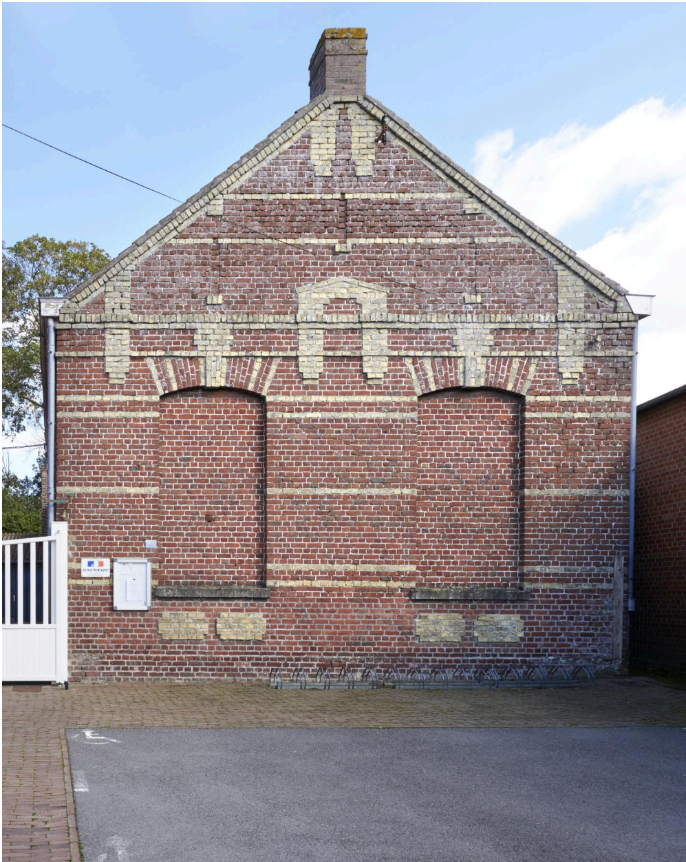
Pignon ouest du bâtiment secondaire.
