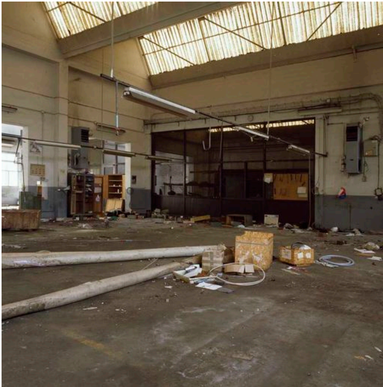
Ateliers de maintenance (chaudronnerie et mécanique).
