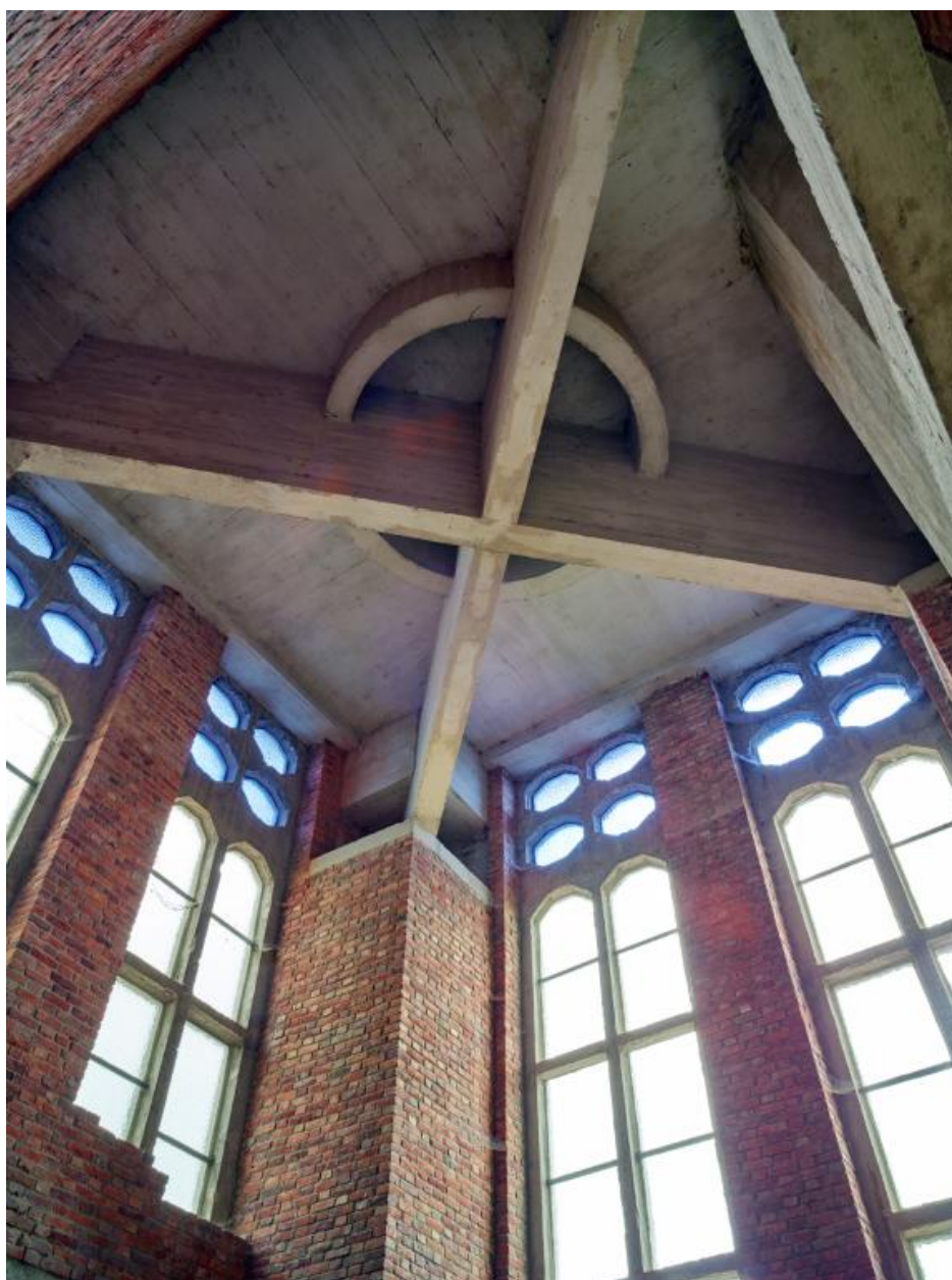
Vue intérieure du clocher. Détail de la structure supportant le campanile.
