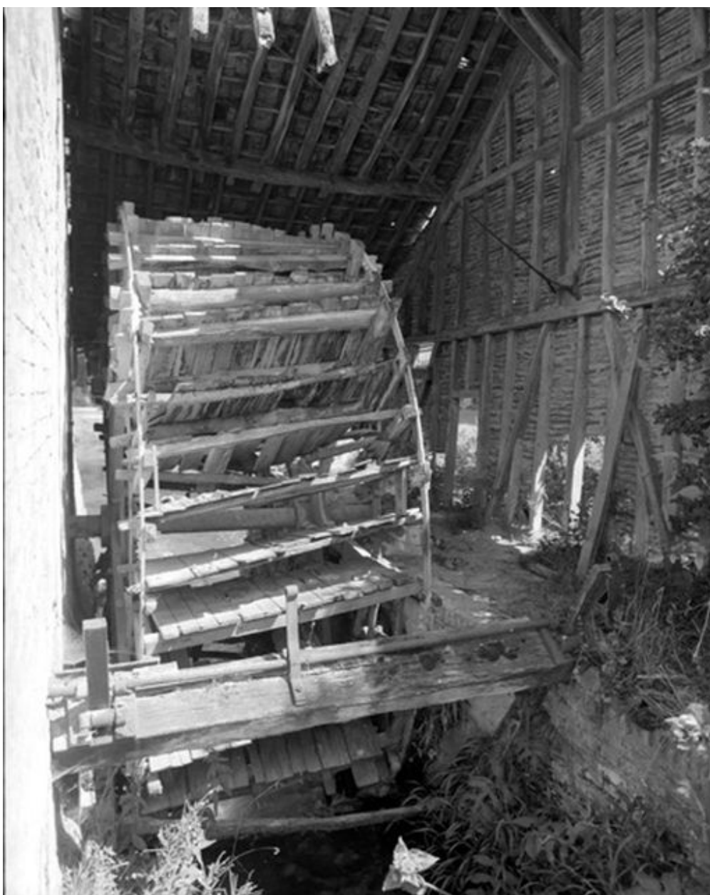
Vue du bâtiment d'eau et de la roue hydraulique verticale.
