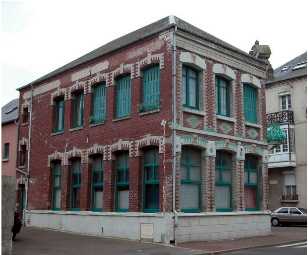
Élévation postérieure sur la cour.
