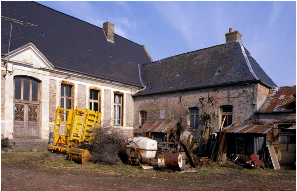
Vue partielle du logis prioral et de son extension en brique.
