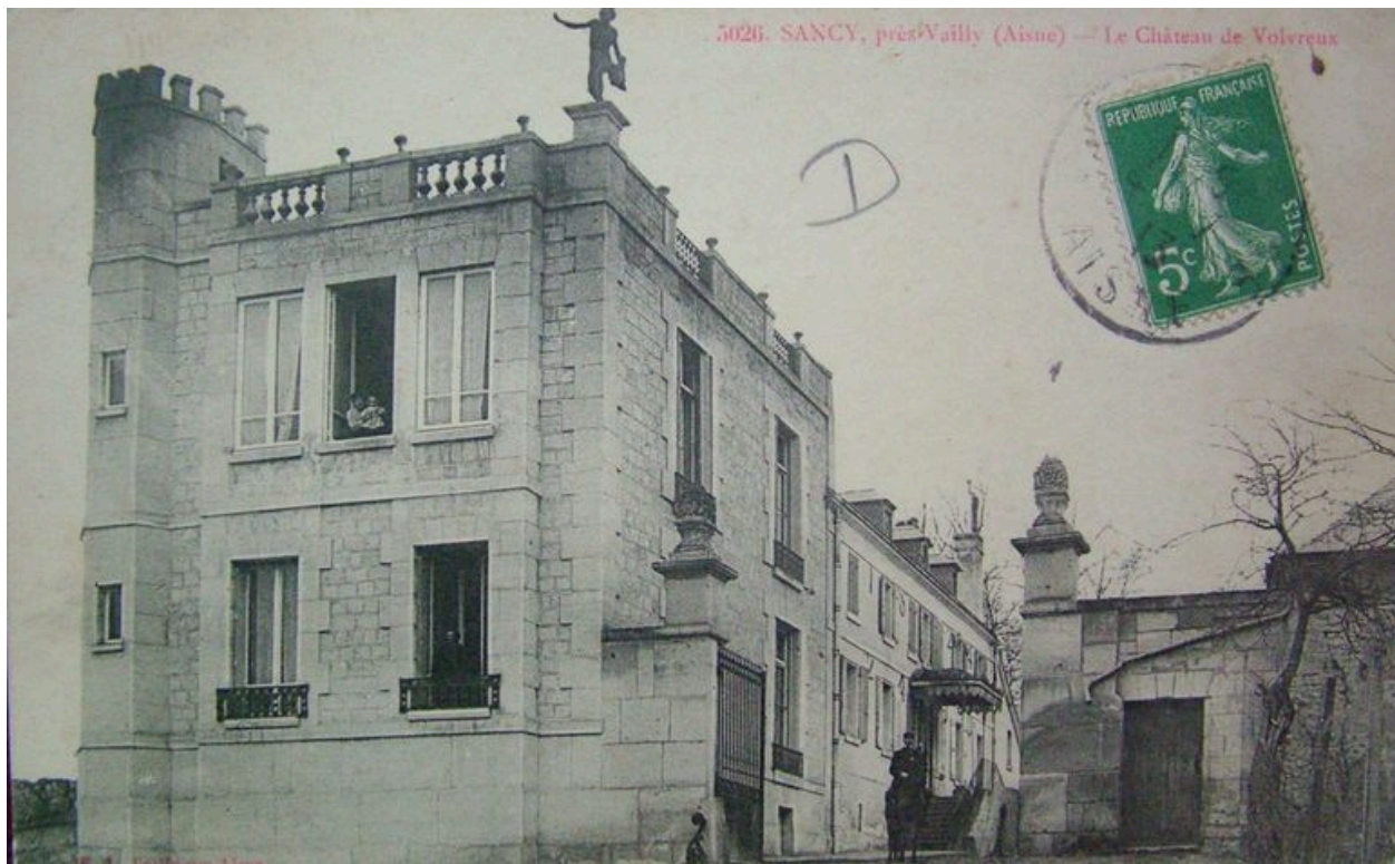
Vue du château de Volvrex avant sa destruction (coll. part).
