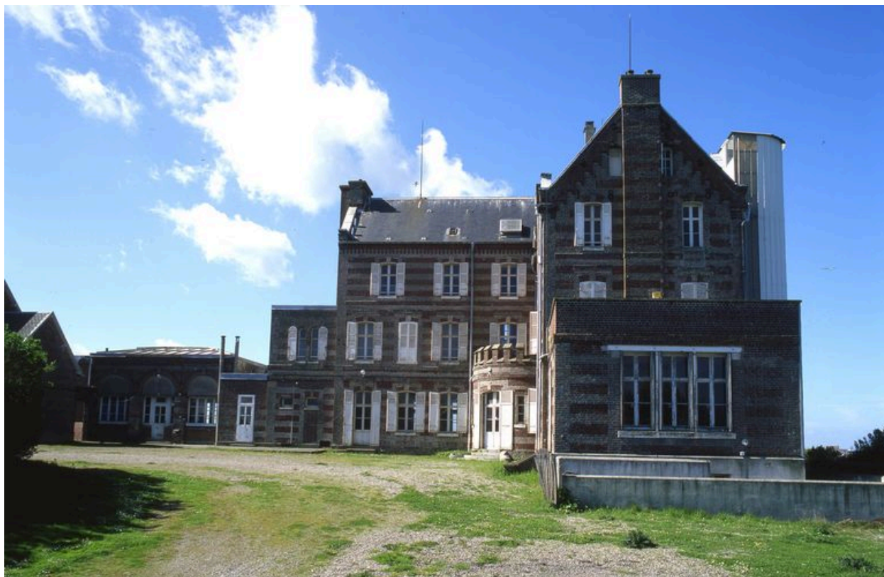
Vue d'ensemble depuis le jardin, façade nord-est.
