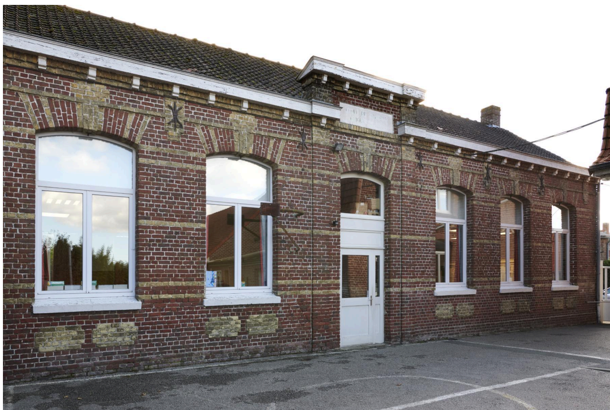
Façade sur cour du bâtiment sud-est.
