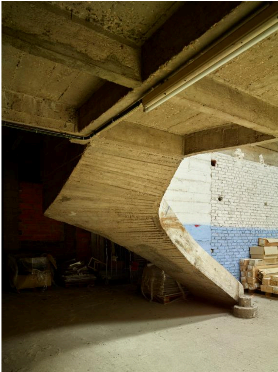
Voûte d'escalier en béton armé.
