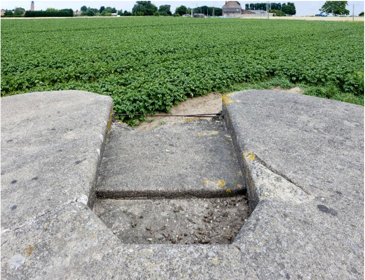
Cuve à mitrailleuse. Vue longitudinale, vers l'est
