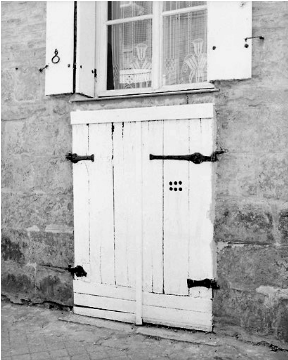
Façade rue Sainte-Barbe, détail : burguet ; état en 2001.
