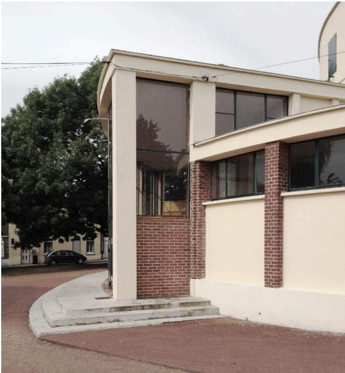
La salle des fêtes. Vue de la façade sud du hall.
