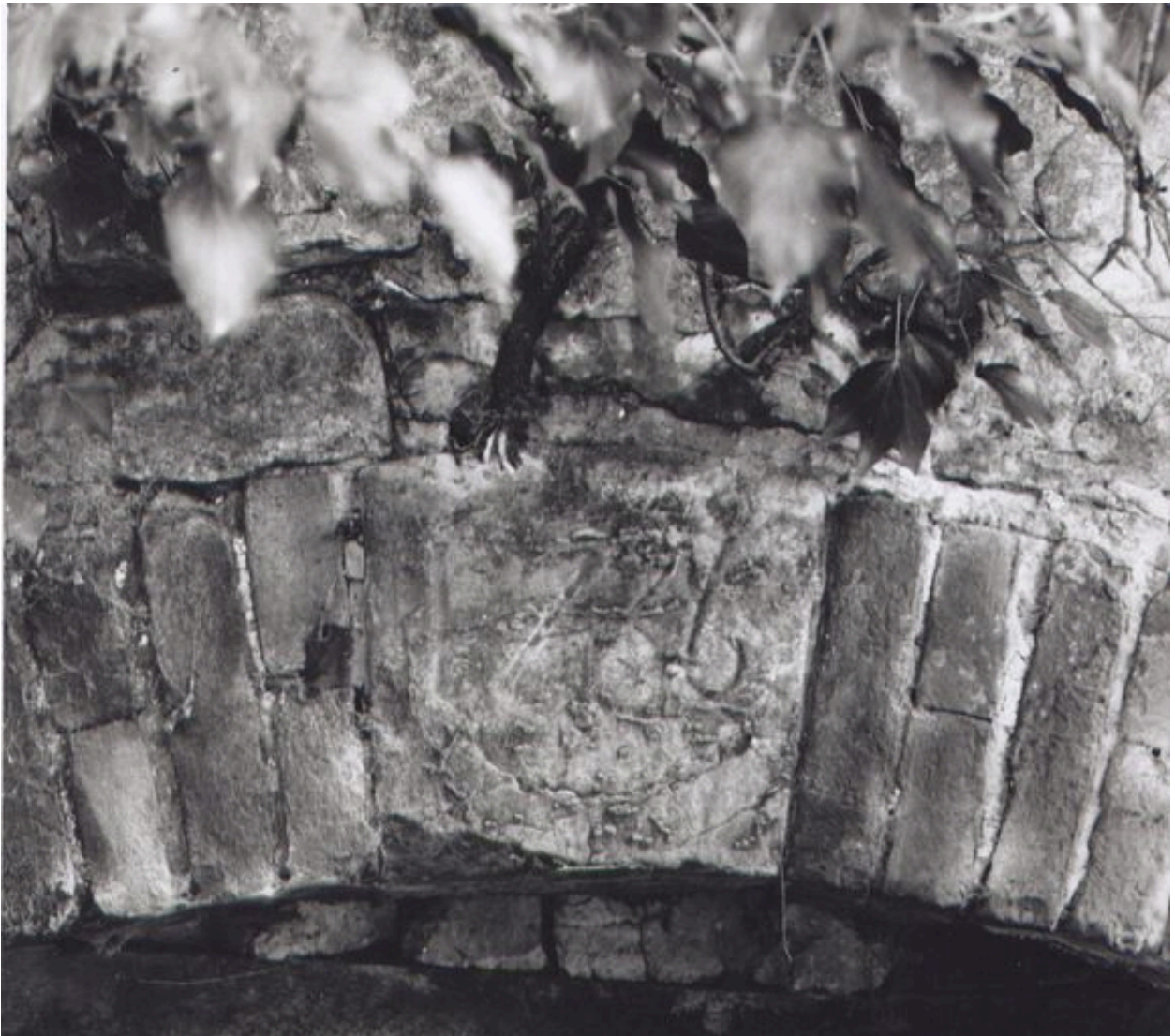
Détail la clef du linteau de la porte d'entrée du moulin portant la date de 1736.
