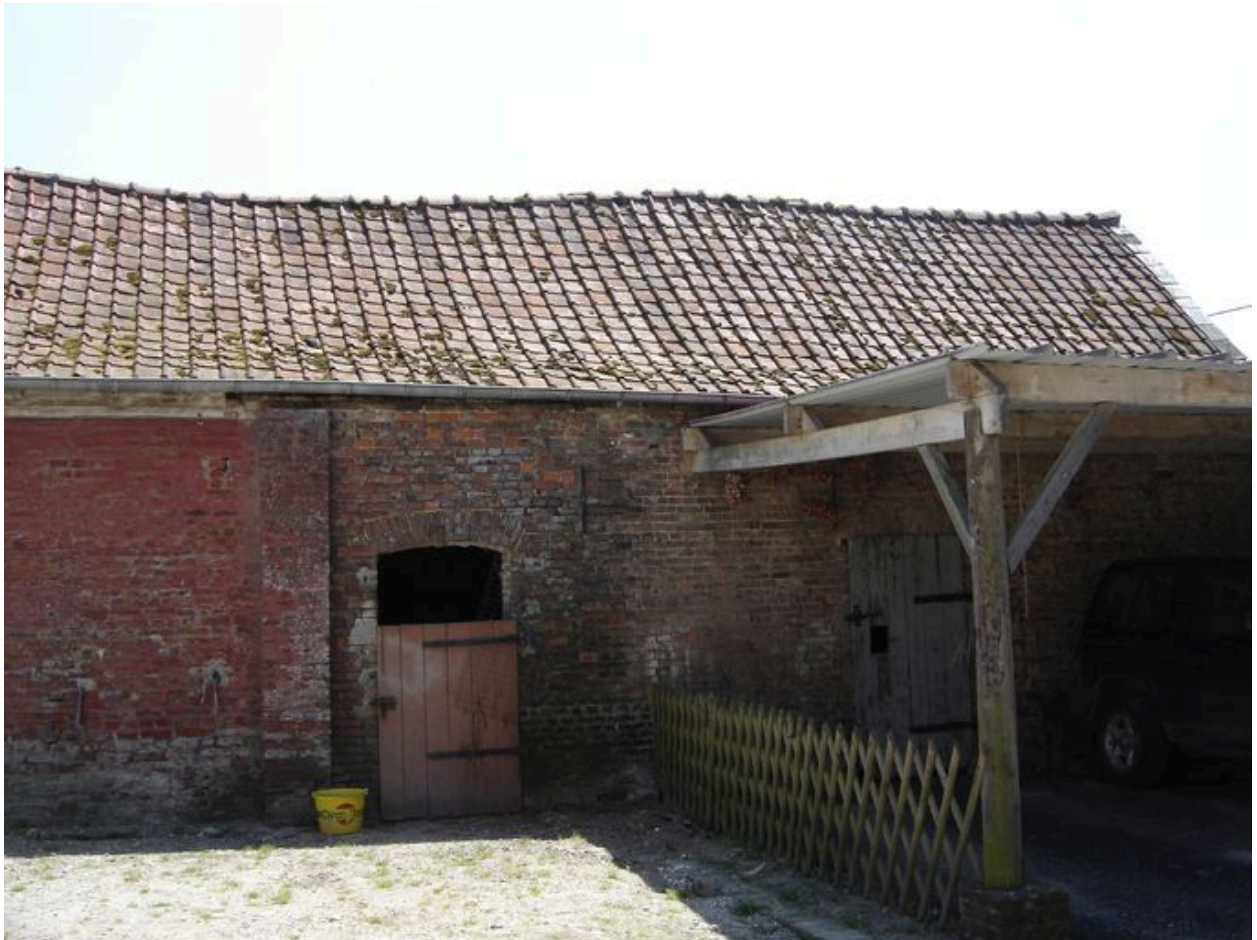
Vue de l'extrémité nord des étables à cochons.
