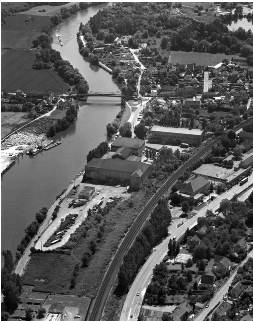
Vue aérienne de la sucrerie avec en arrière plan le pont de Saint-Leu, 1995 (Sanson Aviation).
