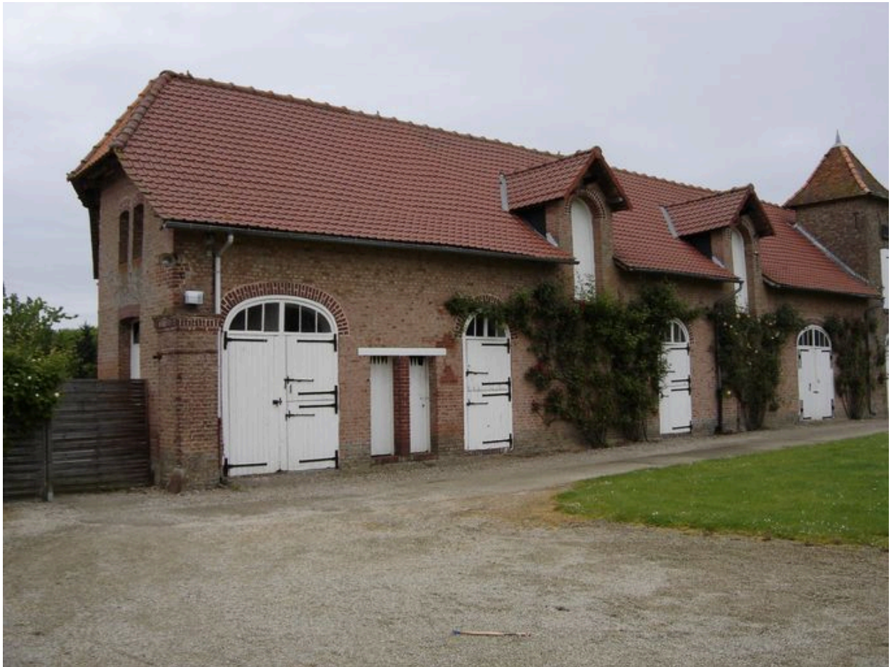
Détail de l'extrémité occidentale du bâtiment nord.
