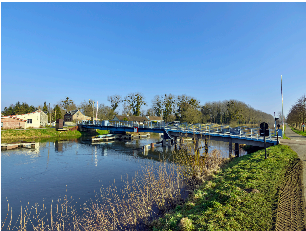
Pont sur la Somme, entre Petit-Laviers et Cambron.
