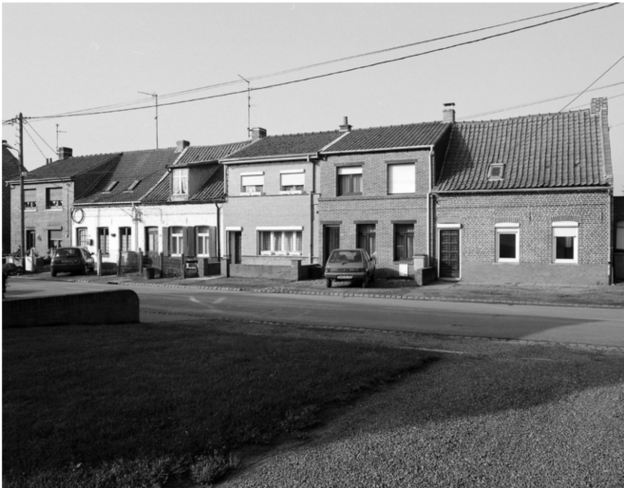
Alignement de maisons en série, rue de la Mairie.
